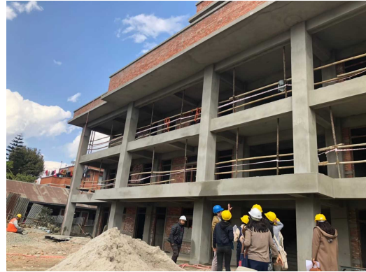
地震で倒壊した小学校の再建現場
