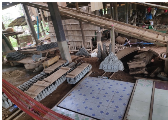
図3：D家族の屋根を作る現場
